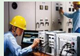
電気設備のメンテナンス
