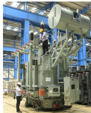
インド現地法人 変圧器製造
