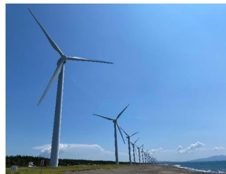
秋田県三種町 八竜風力発電所
