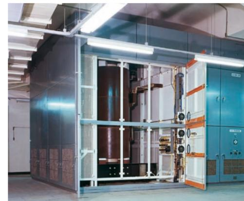
ビル内変電所用変圧器(31.5/6.3kV 7,500kVA)
