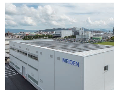
蓄電併設型太陽光発電システム
