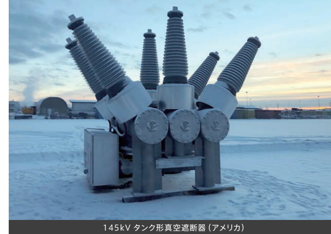
145kV タンク形真空遮断器 (アメリカ)
