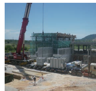
特高変電設備工事（マレーシア）
