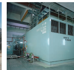
ガスタービン発電設備工事
