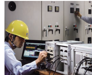
部分放電診断
