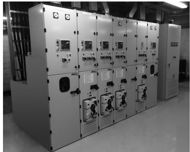
Fig. 5 DC Switchgears
