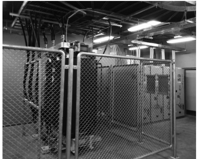
Fig. 8 Rectifier Transformer
