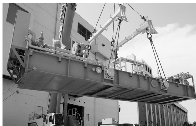
第2図 エンジン用架台荷卸し時の状況
