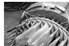
第16図 実機大コイル絶縁検証試験
