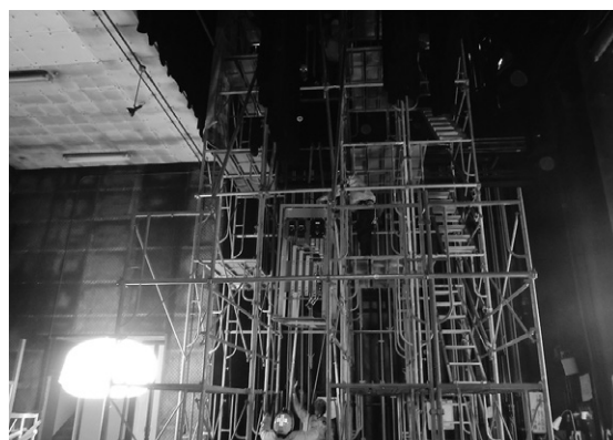
第8図 分割盤の搬入状況
