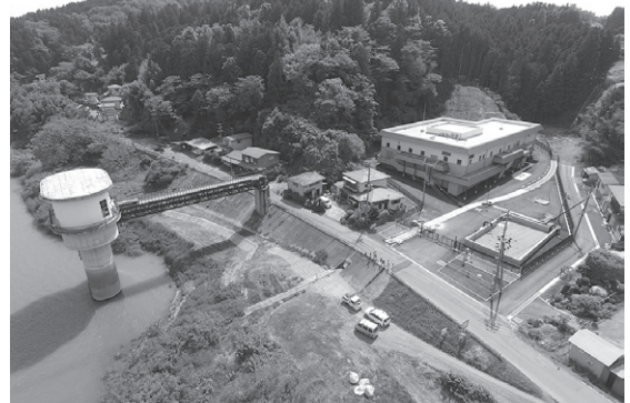
第2図 下り松ポンプ場
