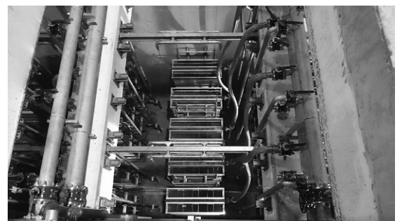
第6図 セラミック平膜MBR設備
