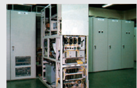
静止形直流高速度遮断器
