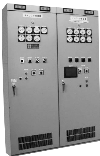
第 10 図 サイリスタ盤 (左)・インバータ盤 (右)
