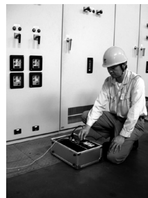
(b) 人工地絡試験器による試験
