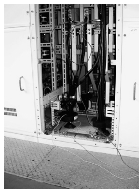
(b) 人工地絡試験器による試験
