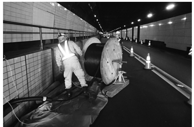
第4図 トンネル坑口部分のケーブル布設作業
