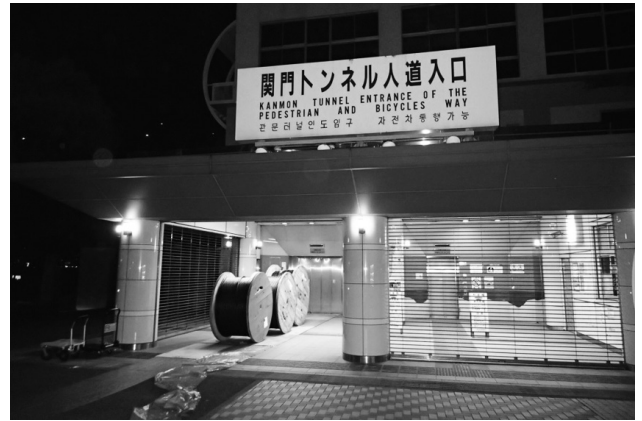
第3図 トンネル内布設用ケーブルドラムの搬入
