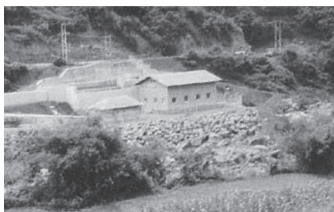
発電棟と屋外変電所
