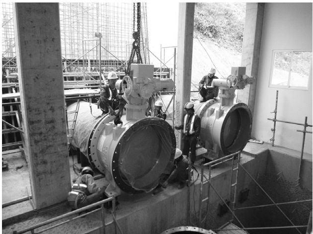
第5図 入口弁据え付け作業
