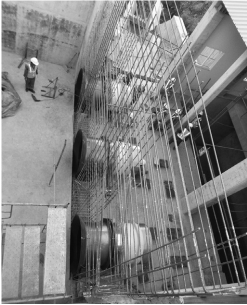
第4図 取水管据え付け作業
