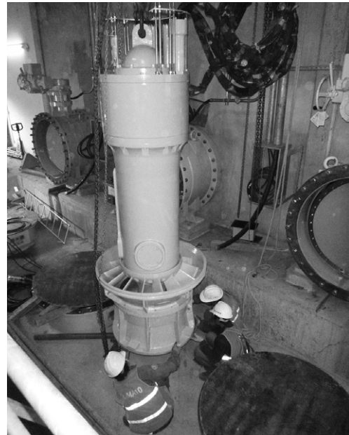
第2図 150kW永久磁石水中タービン発電機
