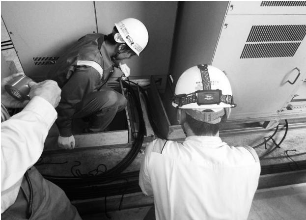
第7図 ケーブル撤去実習
