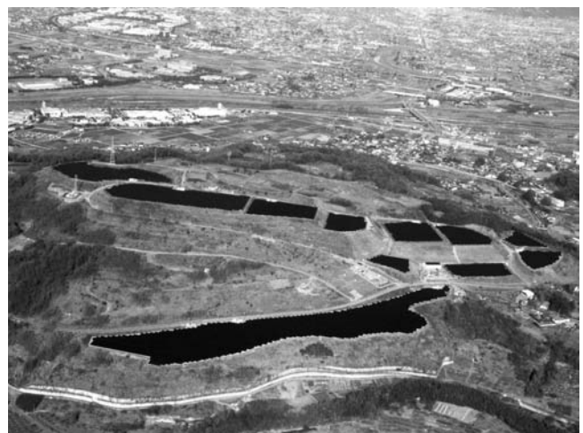
第35図 米倉山太陽光発電所全景
