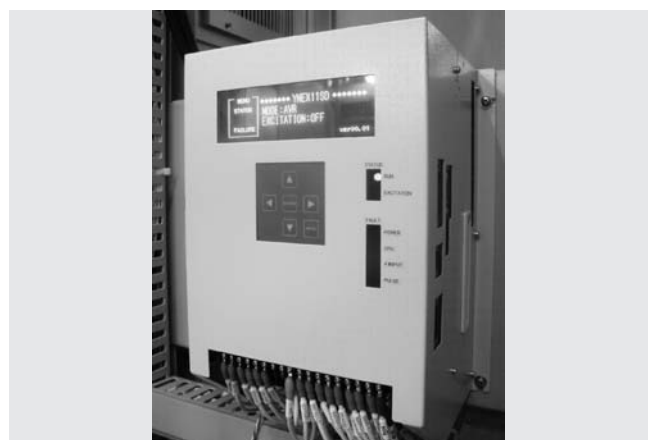
第6図 デジタル式静止励磁装置（YNEX11SD）
