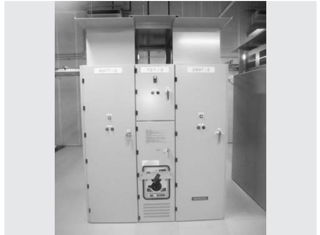
第28図 ML形HSCB収納盤
