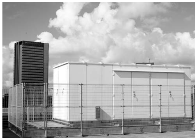
第37図 リチウムイオン蓄電池システム（横浜ワールドポーターズ屋上）
