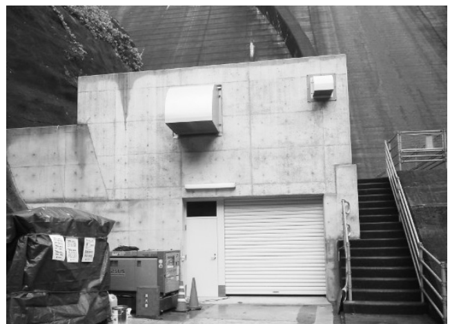
第5図 水力発電所
