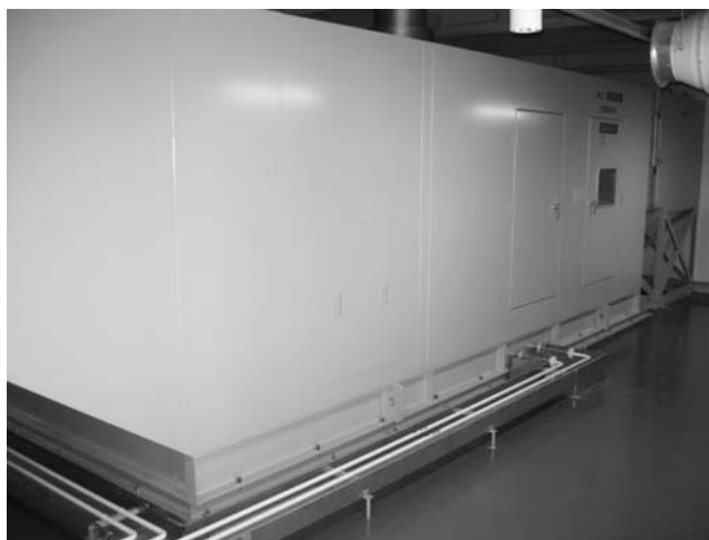
第13図 大形非常用ディーゼル発電装置
