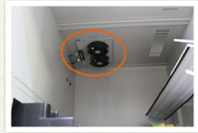
▲キュービクル内の温度上昇を抑えるための冷却ファン
