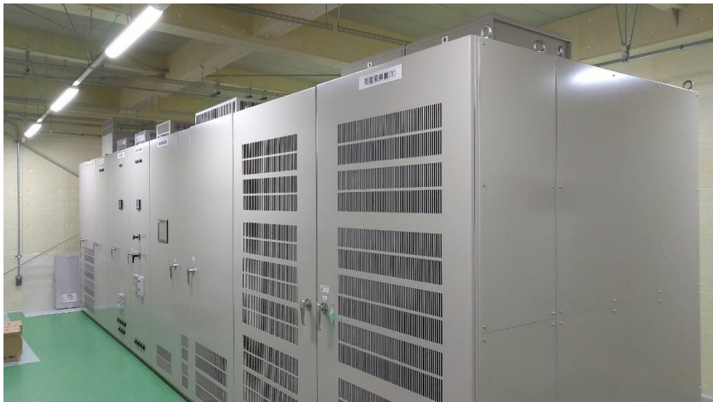
JAXA 美笹深宇宙探査用地上局に納入された 瞬低補償機能付き NAS 電池用交直変換装置
