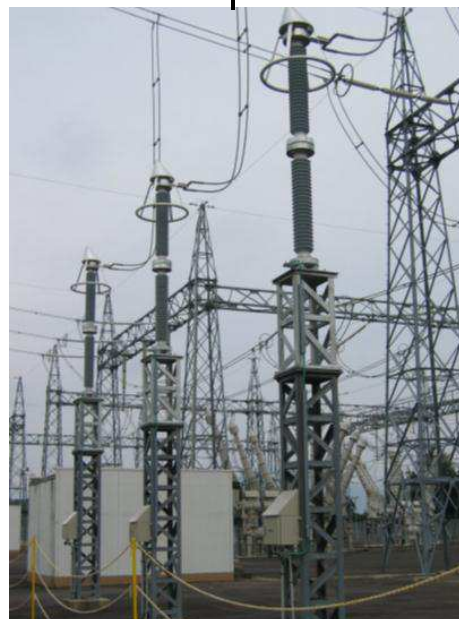
275kV用 ポリマー形避雷器 (耐震性向上形)
