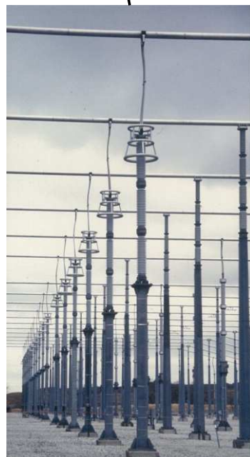
500kV用磁器形避雷器
