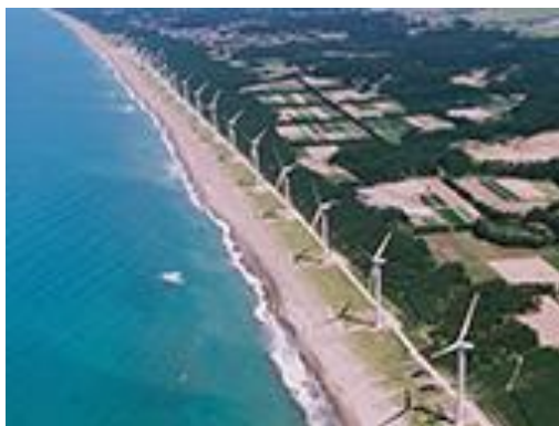
八竜風力発電所
