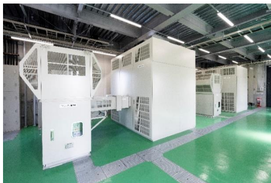
シリコン整流器・整流器用変圧器
