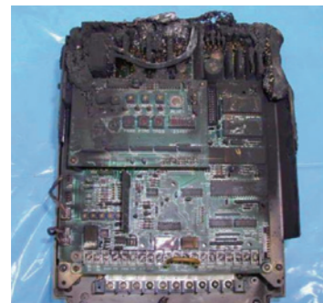
汚損によるAVR制御部の焼損
