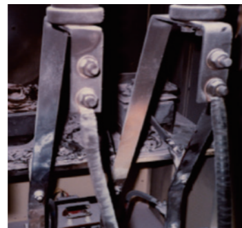
絶縁劣化によるPTの焼損
