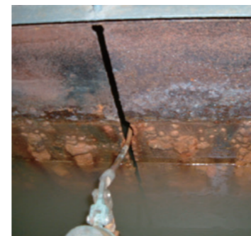
冷却水槽内部の腐食
