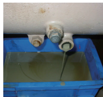
冷却水混入による潤滑油の乳化
