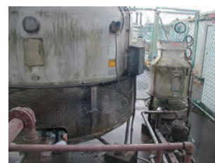
空調用ポンプインバータ化
