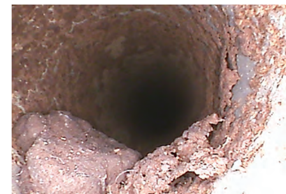
発電機空気冷却器配管内部
