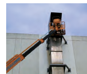
ガスタービン排気口の臨時点検
