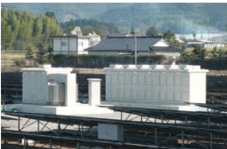
パワーコンディショナ(右)と高圧連系設備(左)
