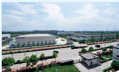
明電舎(杭州)電気系統
