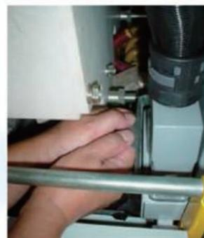
⑤ 機器の制御電源を開放し、コネクタのロックを押し下げ、コネクタを外し、盤より機器を引出せる状態となります。
