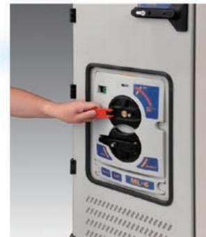
① 機器が切状態であることを確認し、引外しレバーハンドルを固定→固定解除の位置へ移動。
