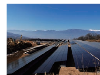
区画2 (2010年度施工) 東側からの様子
