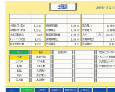
主機監視画面
