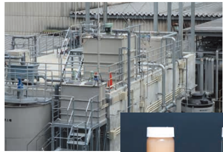
排水処理設備
