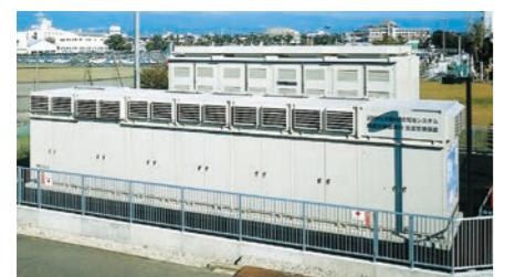
電力使用量の少ない夜間に電力を蓄え、昼間に供給することにより負荷平準化を図り、CO<sub>2</sub>削減とコスト削減に貢献します。
