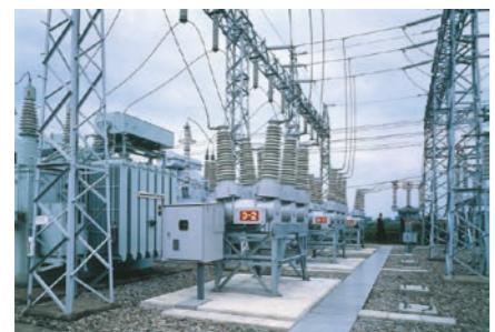
遮断部に真空インタラプタを使用し、対地絶縁のために絶縁ガス(SF<sub>6</sub>ガス)を使用したタンク形真空遮断器です。
