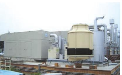
CGSは原動機(ディーゼル・ガスエンジン・ガスタービン)により発電機を駆動し、電力供給と同時に原動機から発生する高温熱エネルギーを蒸気または温水で熱回収し、省エネルギーに貢献する経済性の高いシステムです。
