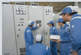
無停電電源装置
