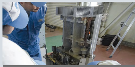
遮断器・開閉器
