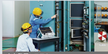
水力発電システム
