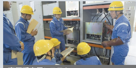
高圧受変電システム
