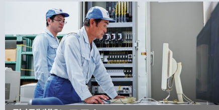
監視制御システム
