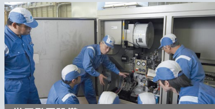
常用発電設備
