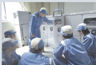
固体絶縁開閉装置
