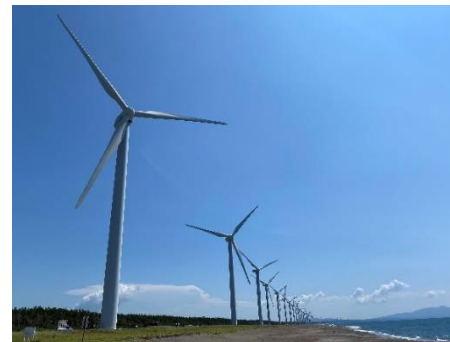
秋田県三種町 八竜風力発電所
